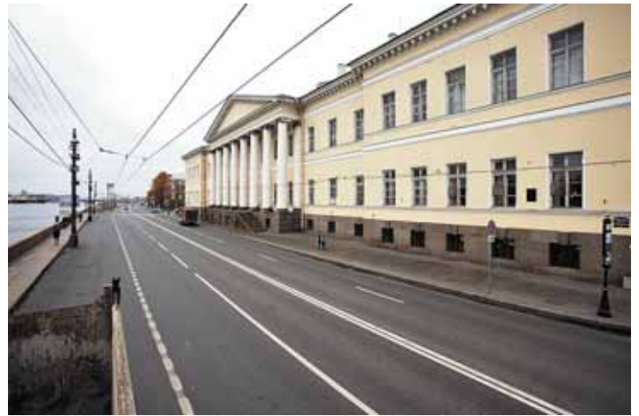
↑ Единственный актив нового отделения РАН — здание на Университетской набережной архитектора Джакомо Кваренги. ФОТО: АНТОН ВАГАНОВ
